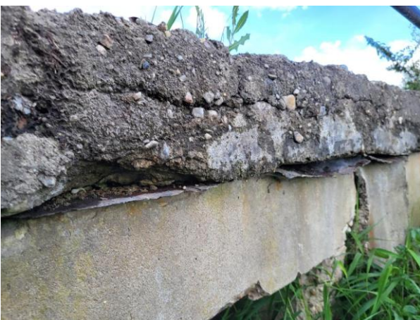
degradace římsy _povodní strana
