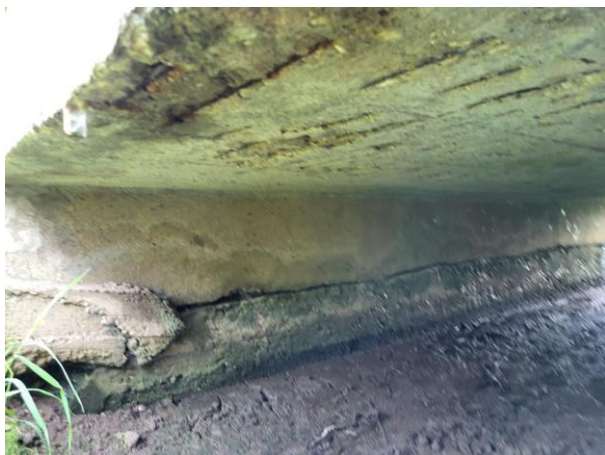
OP2 a degradace podhledu nosné konstrukce
