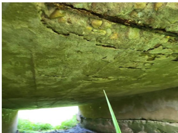
pohled nosné konstrukce _obnažená a korodující výztuž
